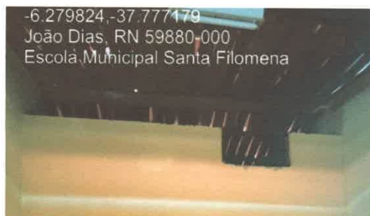
Figura 2a: Estrutura de cobertura
