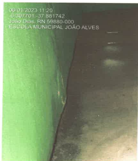
Figura 7a: Deslocamento do piso.
