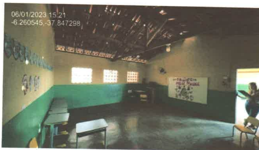
Figura 2a: Estrutura de cobertura
