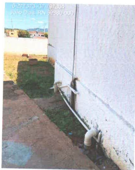
Figura 6: Instalações Hidrosanitárias expostas.
