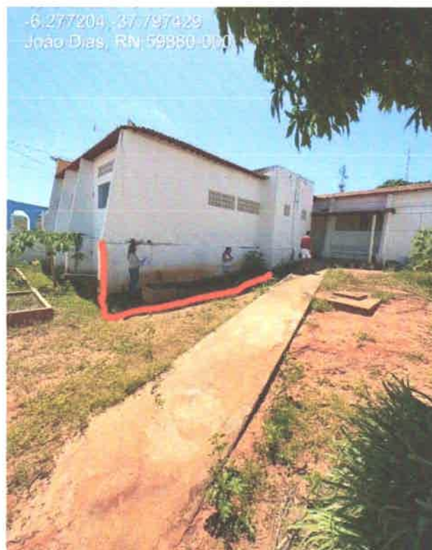
Figura 5: Área que será agregada a cozinha atual.
