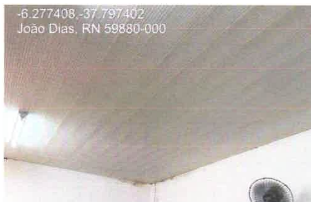
Figura 2a: Estrutura de cobertura
