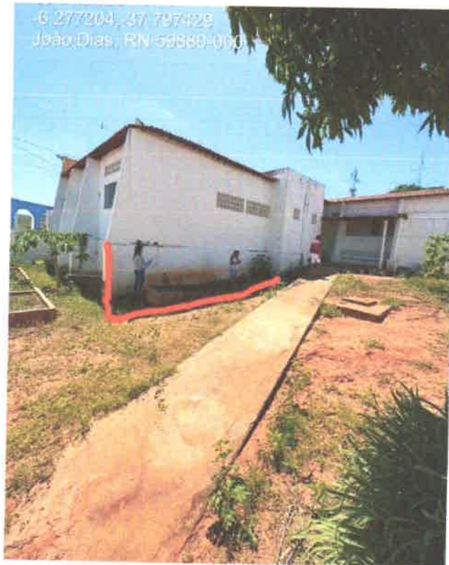
Figura 5: Área que será agregada a cozinha atual.
