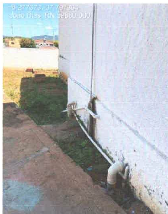
Figura 6: Instalações Hidrosanitárias expostas.
