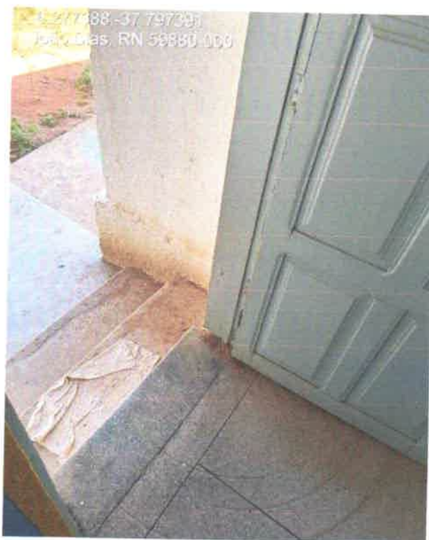
Figura 7: Degraus de acesso para o muro e parque de recreação.
