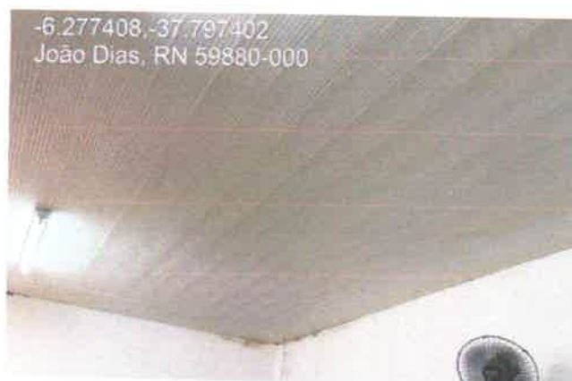
Figura 2a: Estrutura de cobertura
